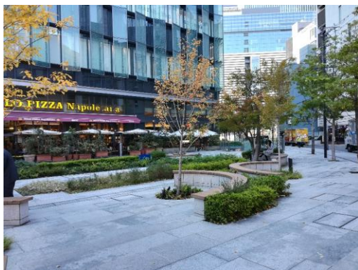
大名古屋ビルヂング
