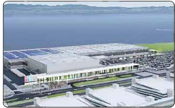
愛知県国際展示場の建設（空港島）
