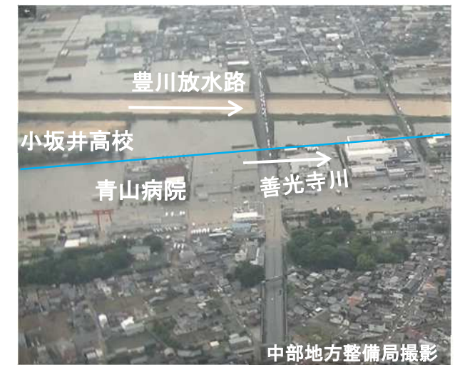
2023年6月2日豪雨 豊川市浸水状況
