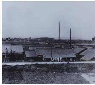
▲ 創業当時の写真。煙突のある建物が工場です。
