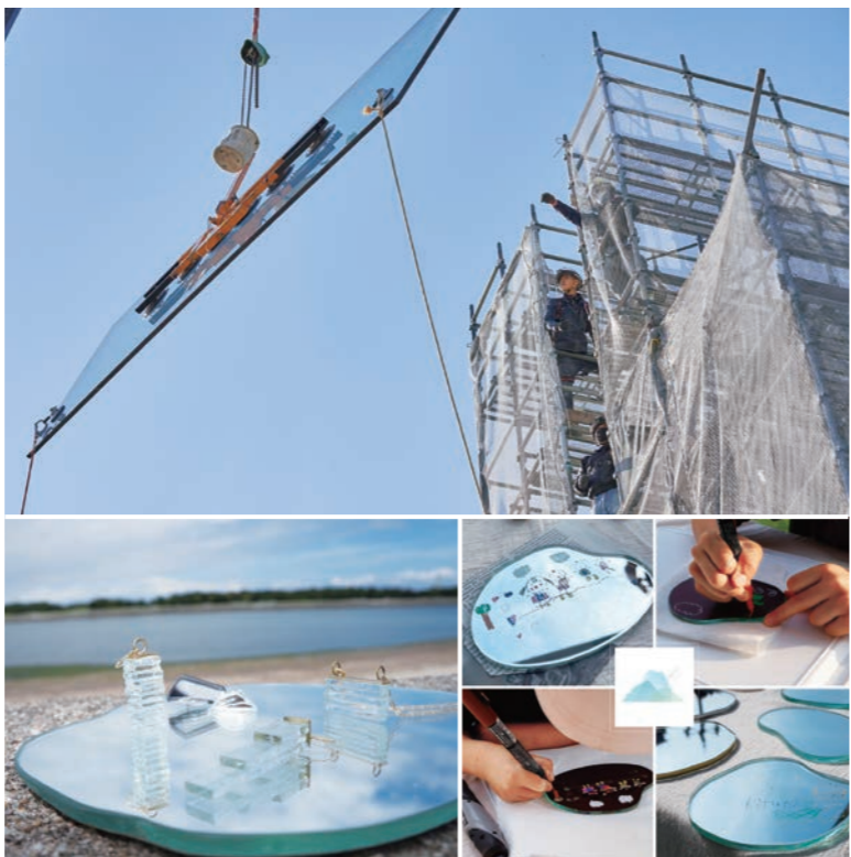
ガラス工事(写真上)では、お客様のご希望に沿ったガラスを提案し、実際の施行まで丁寧なサポートを行っています。ガラスに接している機材(吸盤)は、本誌の表紙で私が手に持っているものになります。また、自社ブランド「gl+」(写真左下)は「光」の意味を持つ「gl」が語源となっています。今後もマルシェなどに数多く出展し知名度を向上させ、ガラス業界自体にも新たな光を当てていきたいと思っています。
